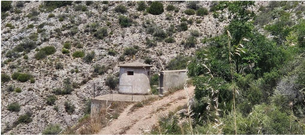
Figura 12. Depósito de planta circular de 50 metros cúbicos de capacidad en Tartareu.
