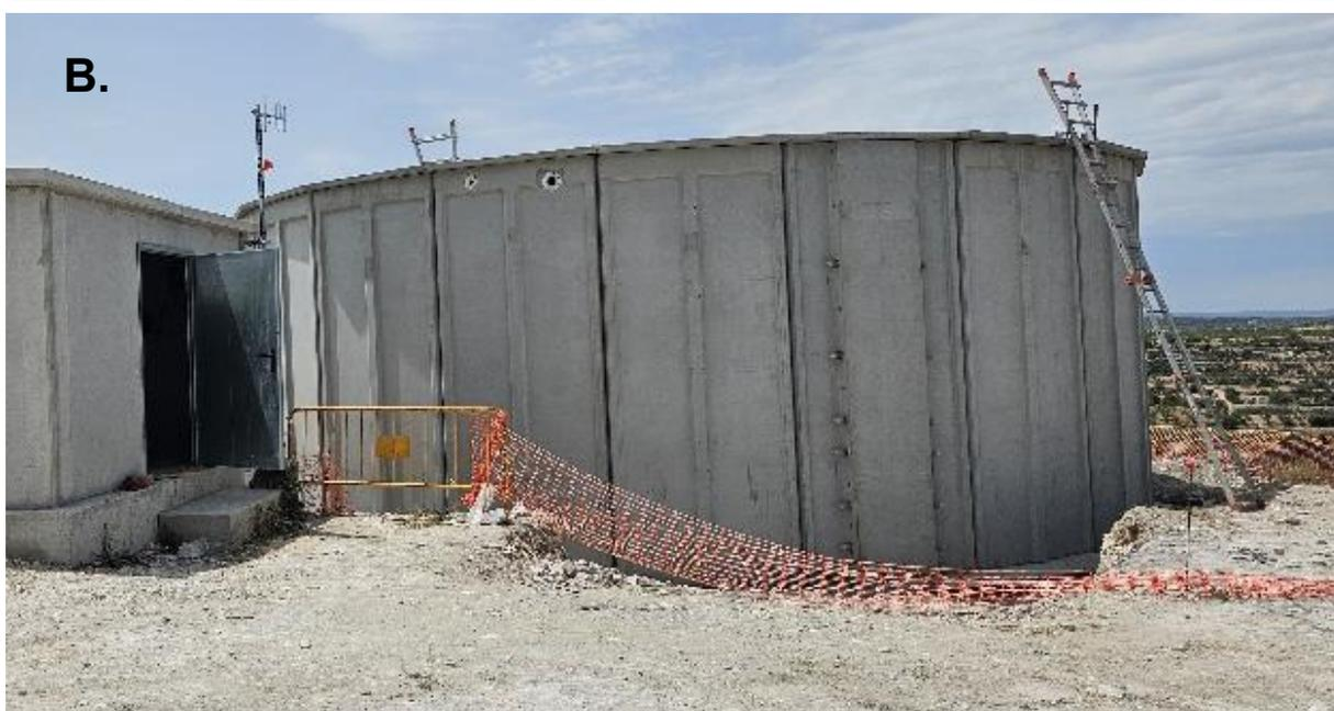
Figura 7. Depósitos de planta circular de 300 (A) y 700 m<sup>3</sup> (B).
