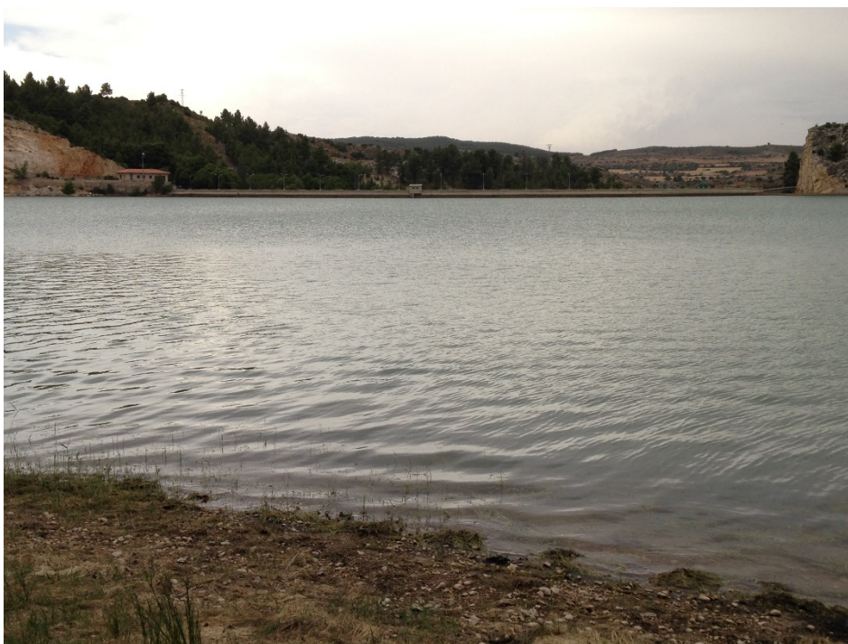
Figura 7. Vista de la presa del embalse
