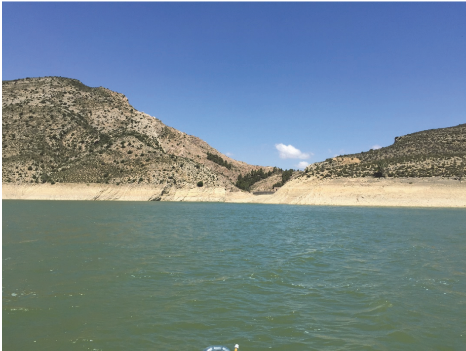
Figura 7. Vista de la presa del embalse
