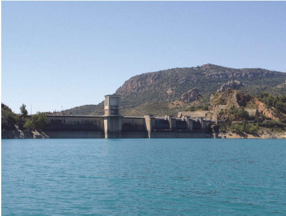
Figura 7. Vista de la presa del embalse
