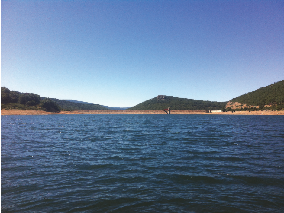
Figura 7. Vista de la presa del embalse
