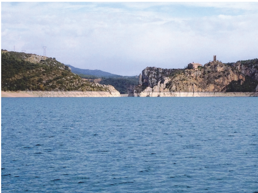
Figura 8. Vista de la cola del embalse
