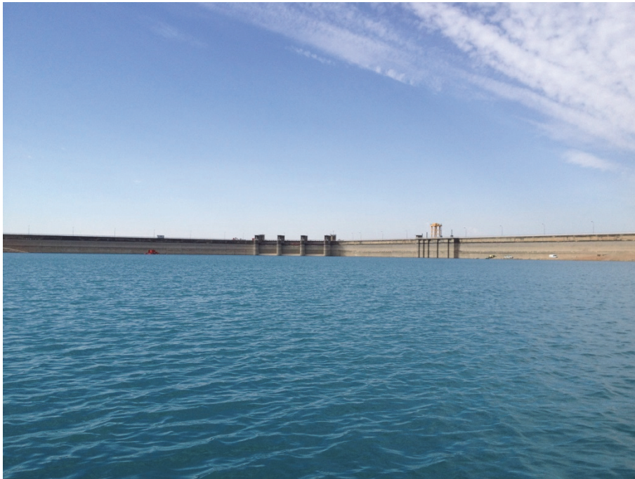
Figura 7. Vista de la presa del embalse
