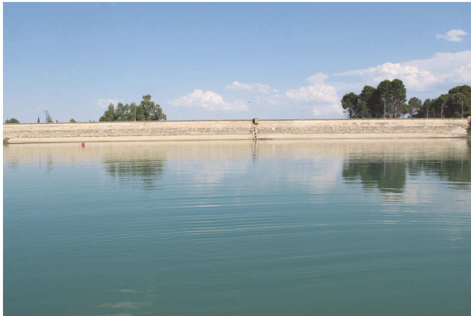
Figura 7. Vista de la presa del embalse
