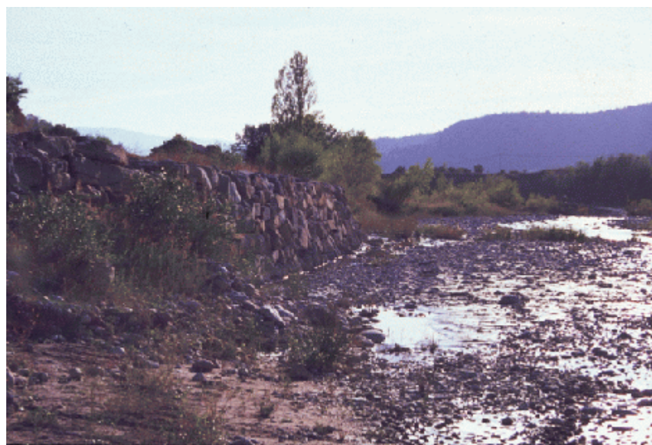
Foto 2.- Mota de piedras, formando una escollera de protección de la carretera.
