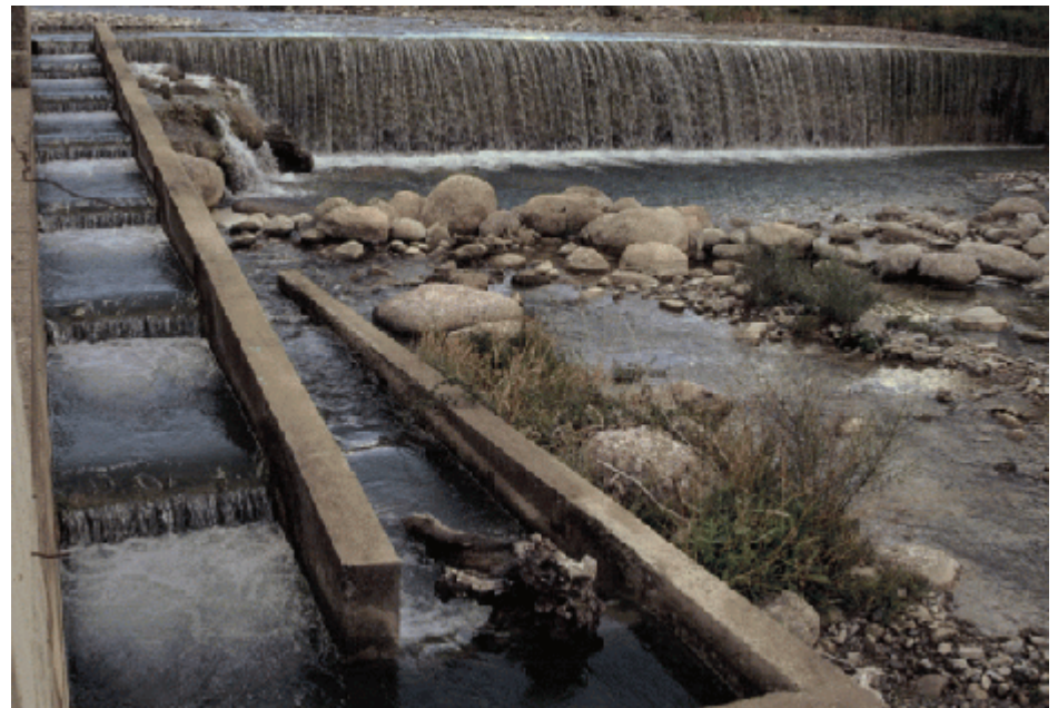
Foto 2.- Azud de Pardinella. Es de cemento, de unos 2 m de alto, y detrae agua hacia un canal. Está equipado con escala para peces.
