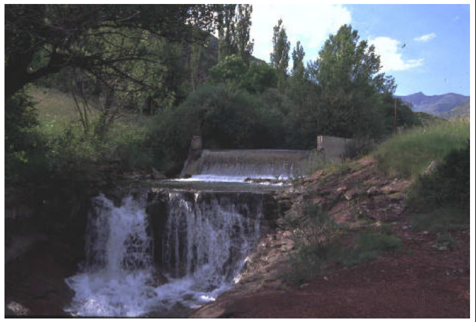
Foto 3.- Último de los cinco puentes que cruzan el río en este tramo. La mayoría son sencillos, de cemento, y dan acceso a prados vecinos.
