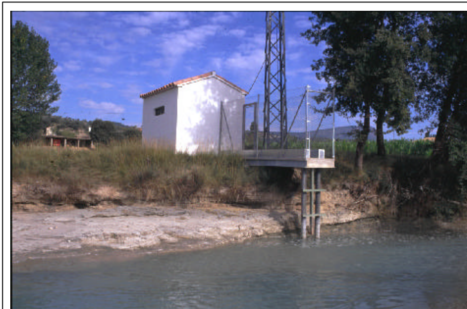
Foto 1.- Toma fija de agua para abastecimiento urbano y usos agrarios, en una poza, cerca de la zona de El Soler.
