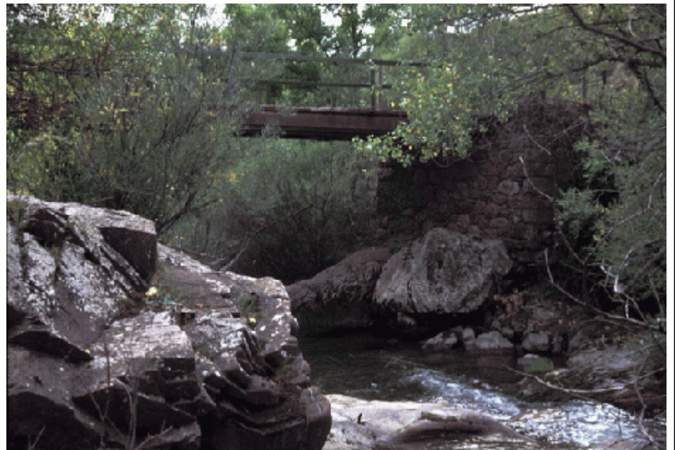
Foto 2.- Último de los cinco puentes que cruzan el río en este tramo. La mayoría son sencillos, de cemento, y dan acceso a prados vecinos.
