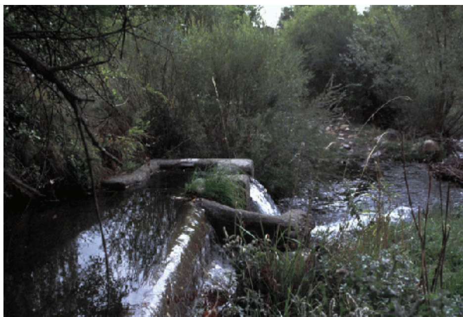
Foto 3.- Toma de agua superficial no inventariada. Permite el paso de peces.
