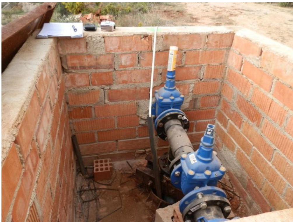
Foto 2. Referencia medida de nivel en tubería de sonda (Miravet). Punto nivelado
