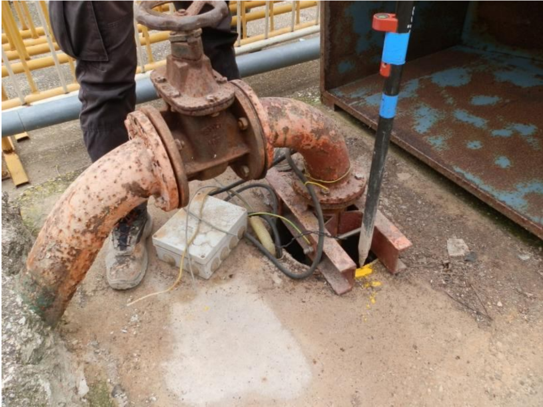
Foto 2. Nivelación pozo 2 Aldover
