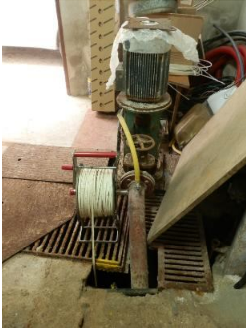
Foto 2. Nivelación pozo 3 Aldover
