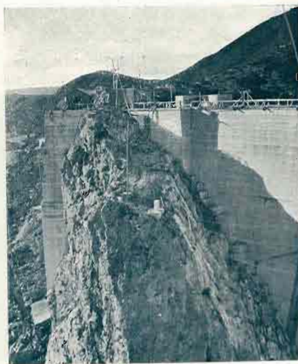
Figura 5.ª ESTRIBO DERECHO DE LA PRESA
