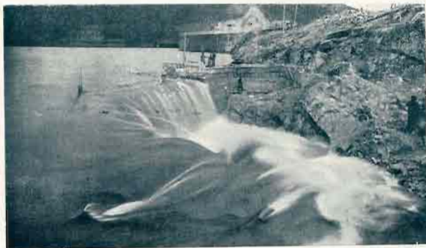
Figura 6.ª LAS OBRAS DEL ALIVIADERO, EN MARZO DE 1930
