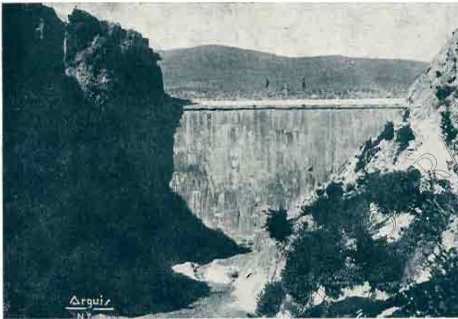
Figura 1. a PANTANO DE ARGUIS. LA PRESA ANTIGUA, VISTA DESDE AGUAS ABAJO
