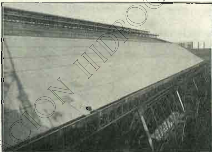
Naves de la nueva estación de M. Z. A. de Barcelona, cubiertas con placa CANALETA
