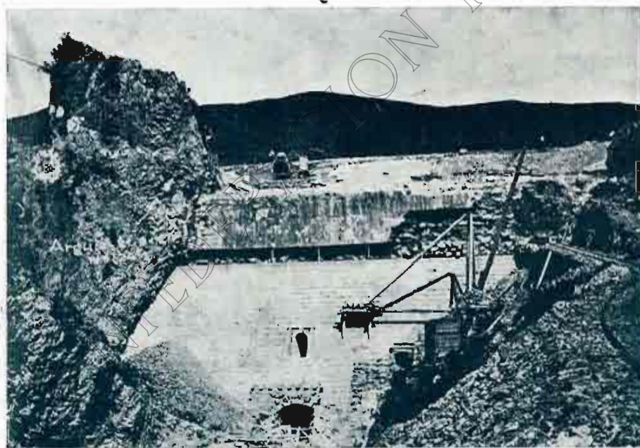
Figura 4.ª CONSTRUCCIÓN DE LA PRESA DE ARGUIS
