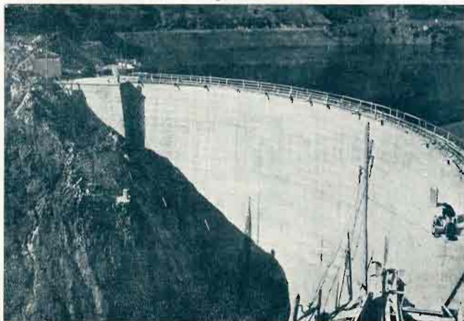
Figura 4.ª VISTA PARCIAL DE LA PRESA DE ALLOZ
