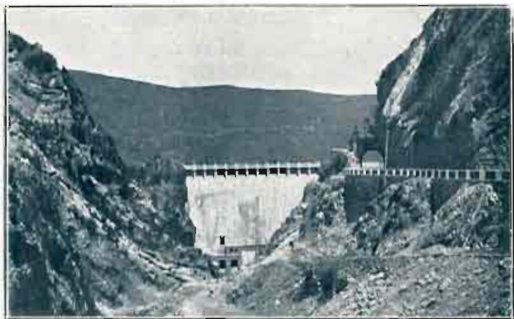
Figura 3.ª VISTA DE LA NUEVA PRESA DE ARGUIS, DESDE AGUAS ABAJO
