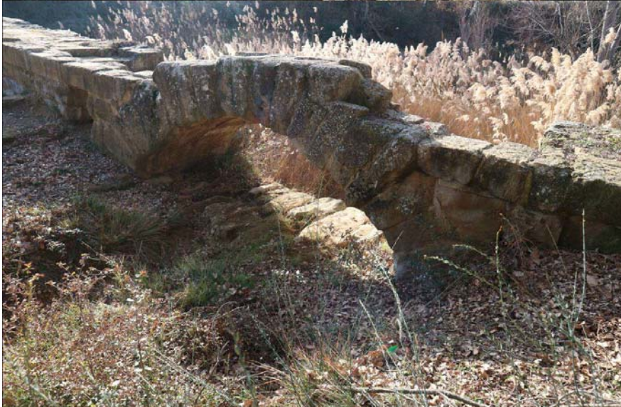
Vistas del acueducto.
