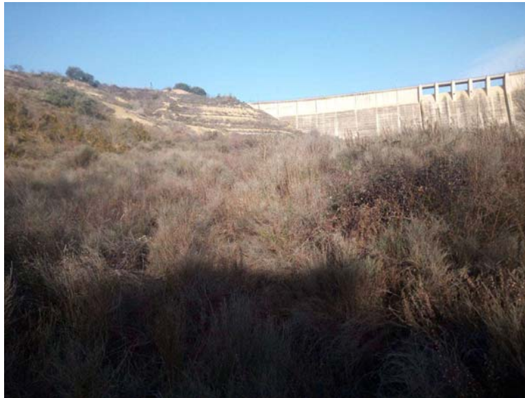
Vista de la presa del embalse, donde arranca la conducción.
