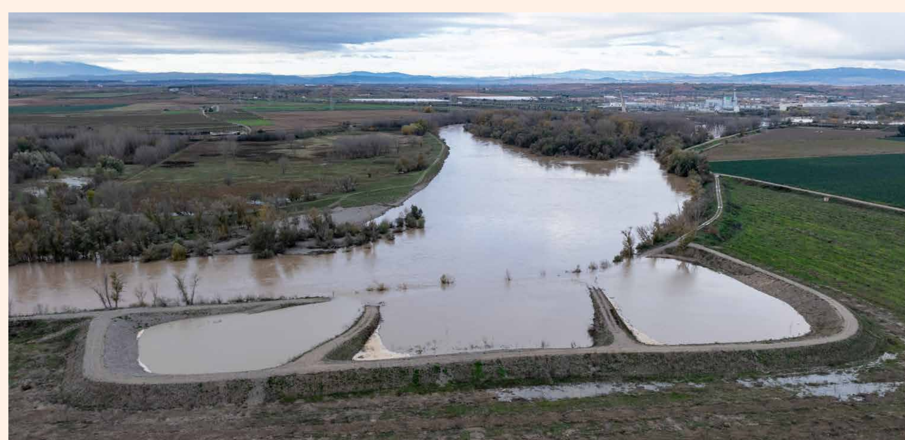
Lóbulos en el río Ebro en Valtierra (Navarra). El Lóbulo es una forma de defensa que no se opone al río, se adapta a las formas que el agua modeló con la erosión de forma continuada.
