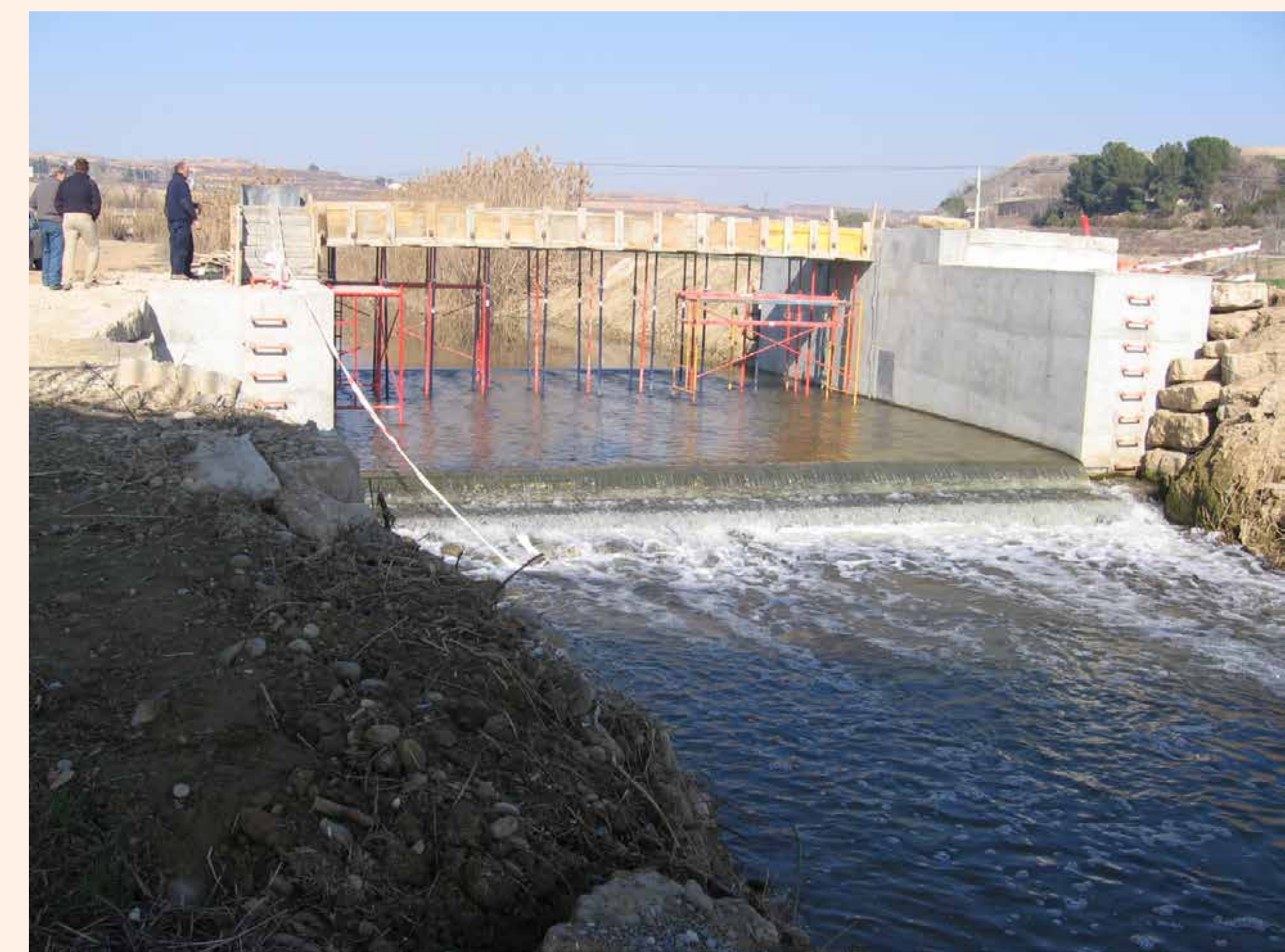
Estación de aforos en construcción en el barranco de la Clamor Amarga o de Tamarite
