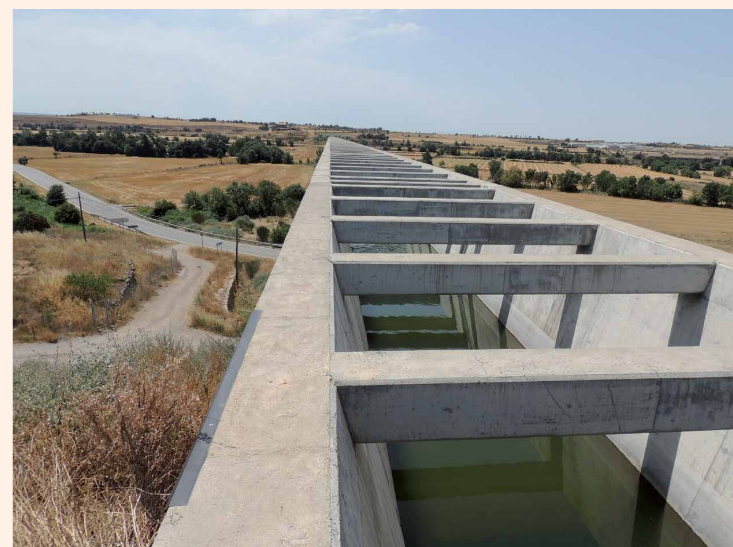
Viaducto del canal de Segarra-Garrigues por el valle del río Sió
