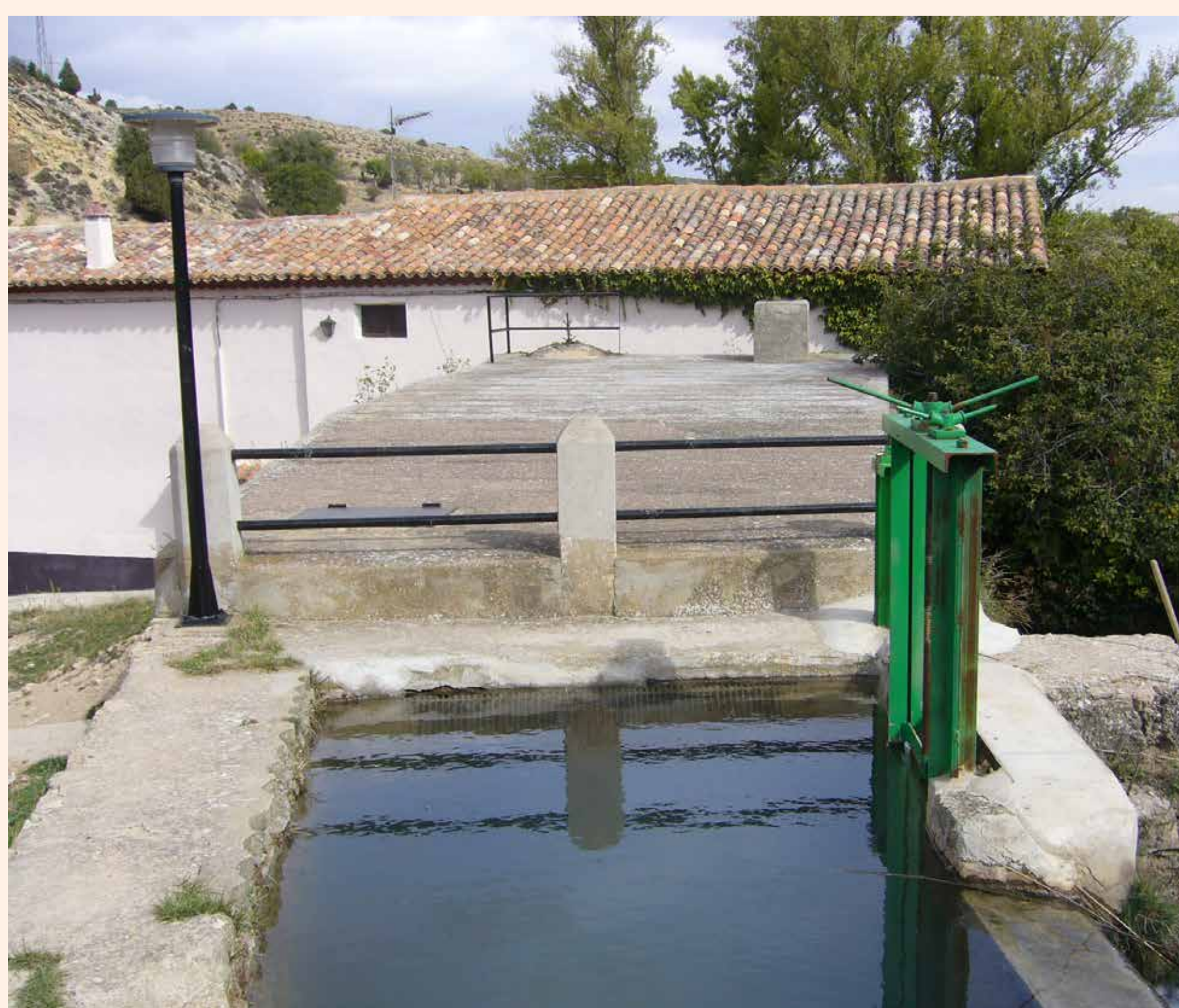
Pequeña central hidroeléctrica en una cabecera de la cuenca del Ebro. (Vilhel de Mesa, Guadalupe)
