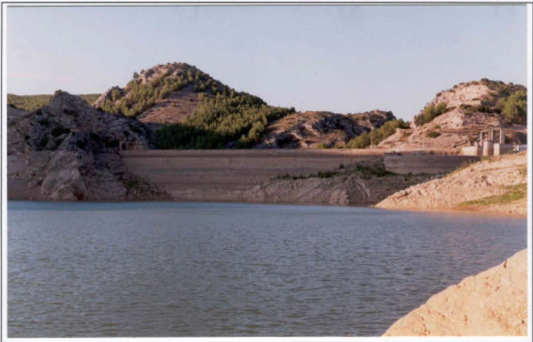
Vista de la presa de Las Torcas.
