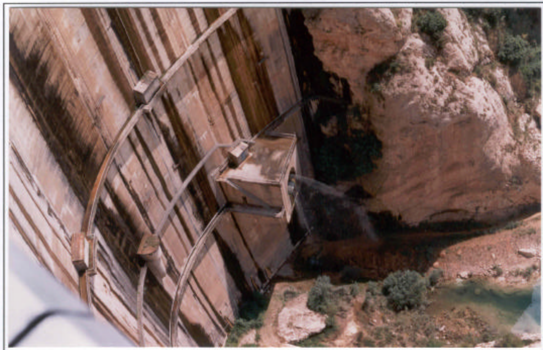
Desagüe de fondo de la presa de Canelles.
